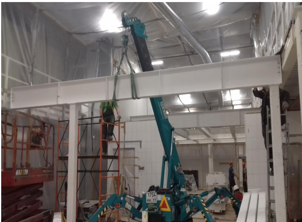
Монтаж каркаса
