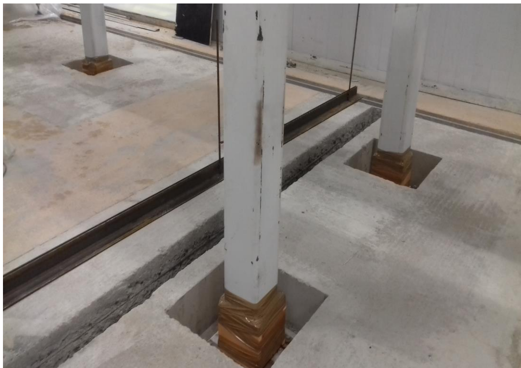
Бетонирование стаканов фундаметов
