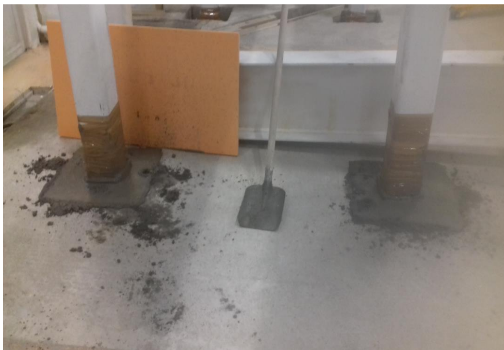
Бетонирование стаканов фундаметов
