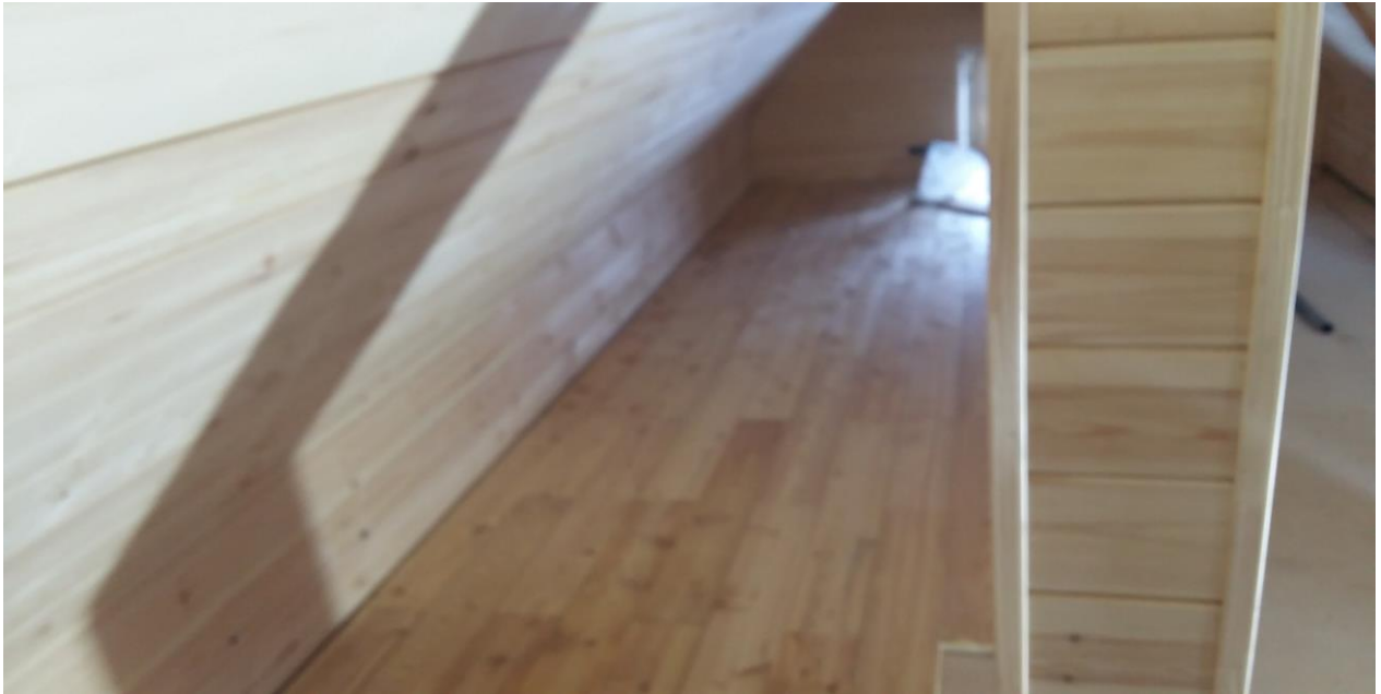
Обшивка доской полов и стен чердака
