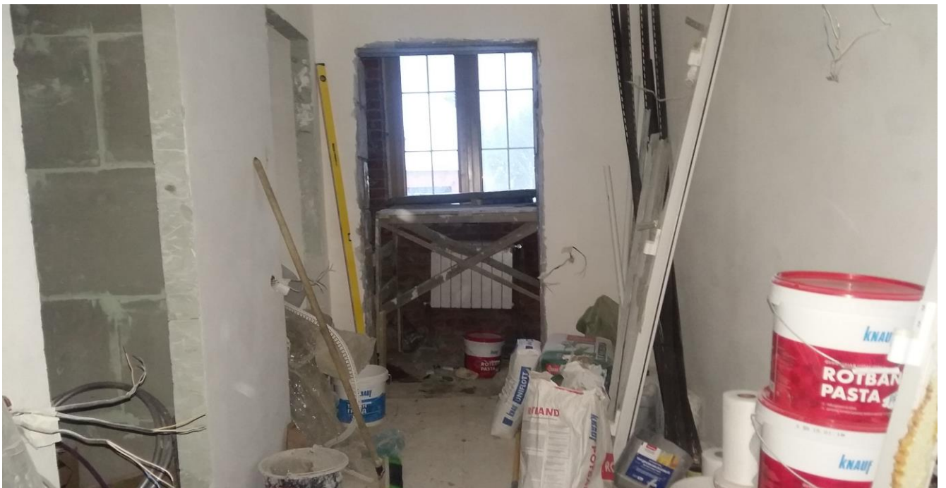
Внутренняя отделка стен
