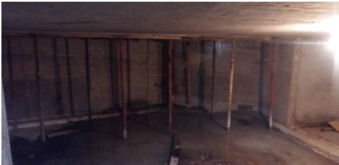
Установка опорных стоек перекрытия
