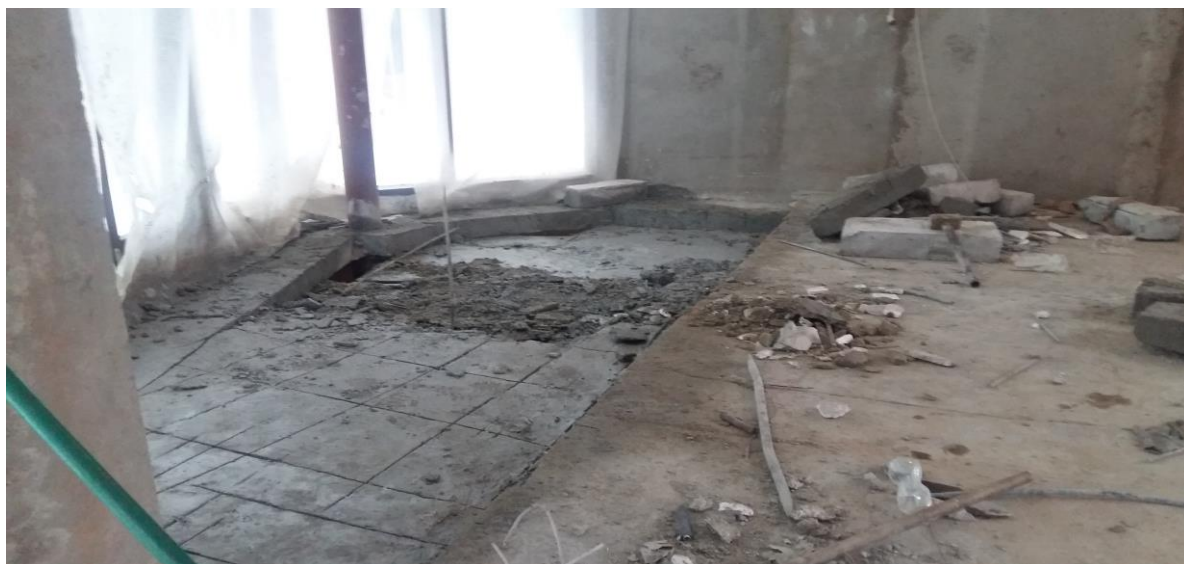
Устройство проема в перекрытии
